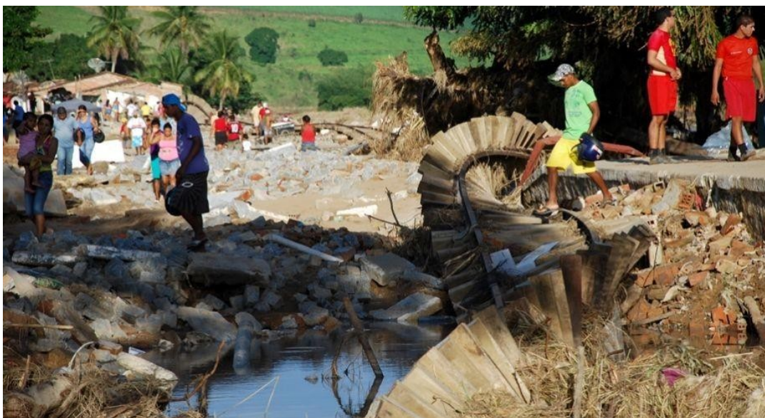
Figura 14 – Estragos da inundação de 2010 – Rio Novo/ Fernão Velho
