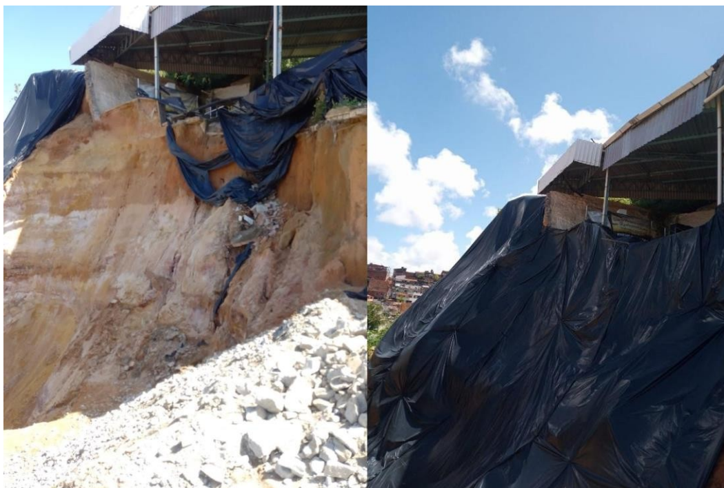
Figura 22. Lona instalada no Santuário da Virgem dos Pobres (85 metros)
