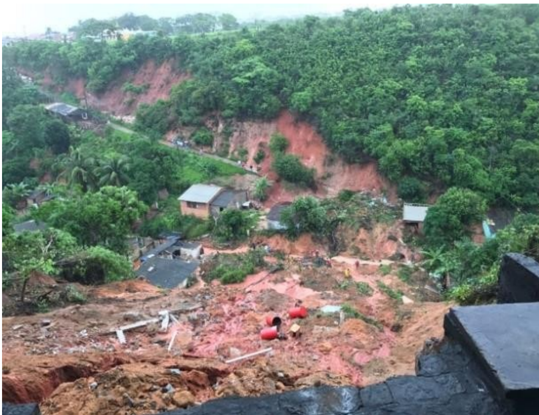
Figura 15 – Deslizamento na Grota do Santo Amaro, em 2017
