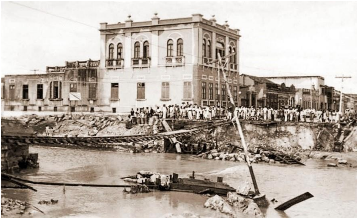
Figura 12 – Avenida da Paz destruída pela tromba d'água de 1949.
